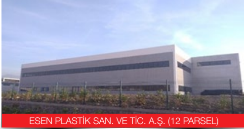
ESEN PLASTİK SAN. VE TİC. A.Ş. (12 PARSEL)
