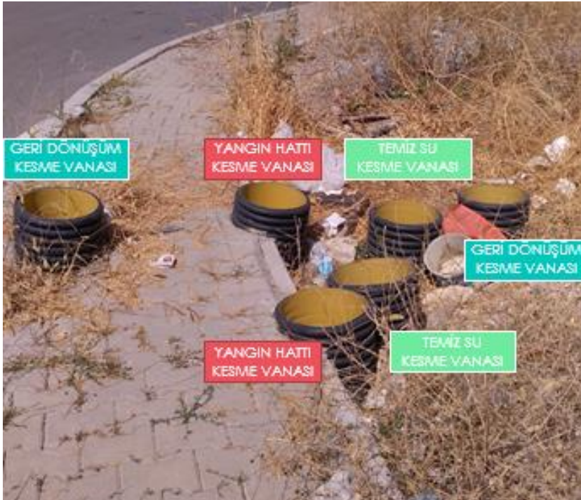
Bölge Altyapısında Kesme Vanalarının Eski Durumu
