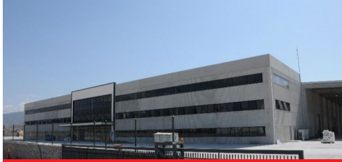
ESEN PLASTİK SAN. VE TİC. A.Ş. (12 PARSEL)
