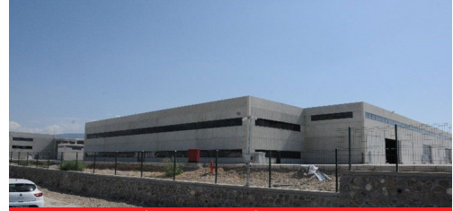
ESEN PLASTİK SAN. VE TİC. A.Ş. (15 PARSEL)
